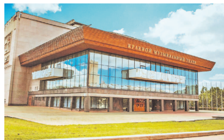
Сегодня остро стоит вопрос с состоянием кровли музыкального театра, который является главной сценической площадкой края
